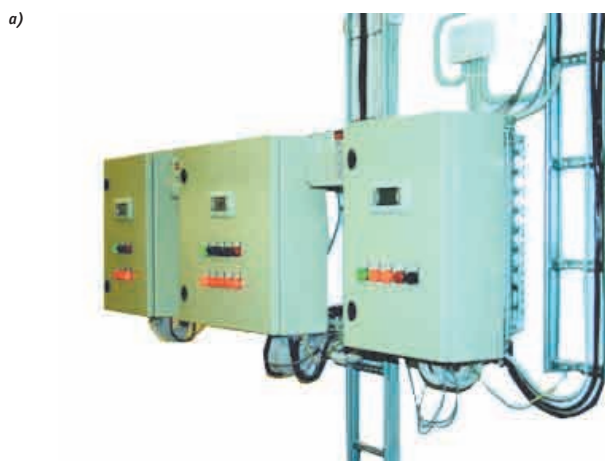
Рис. 1. Щит автоматики: а) снаружи, б) внутри
