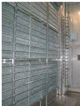
Рис. 3. Работа увлажнителя humiFog в составе центрального кондиционера
