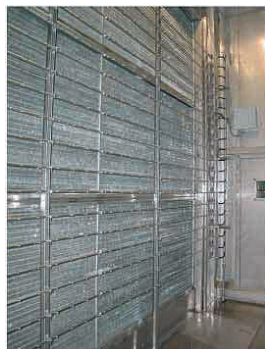
Рис. 3. Работа увлажнителя humiFog в составе центрального кондиционера
